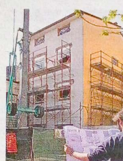
Il cantiere a Porto
